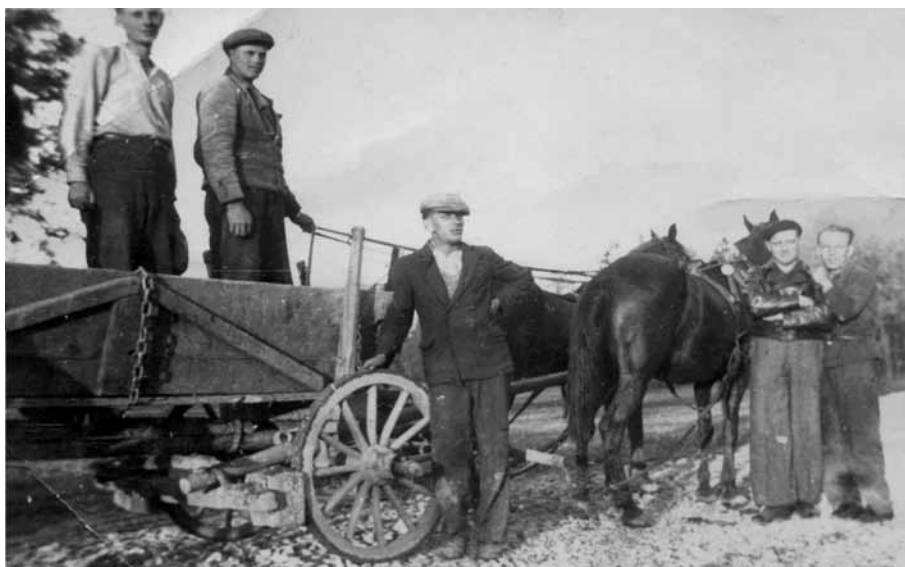
Výstavba mostu na okresní silnici v Dolních Třanovicích, druhý zleva František Czakon, r. 1935
