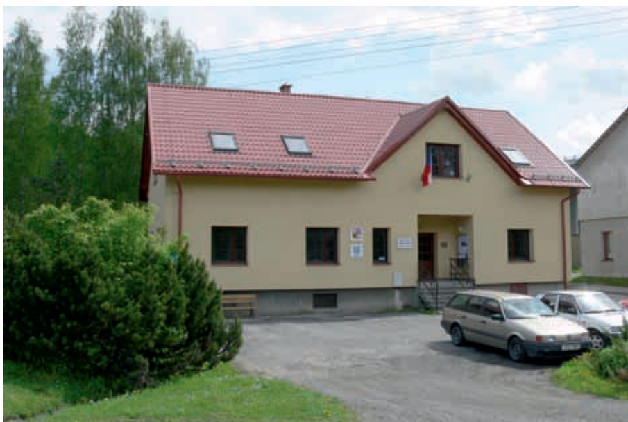
XXVII. Současné sídlo Obecního úřadu Třanovice v centru obce, r. 2010
