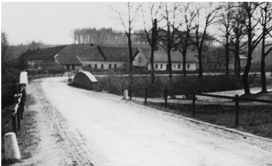
Pohled na Kapplův dvůr a most přes Stonávku ze silnice vedoucí do Hradiště, r. 1940
