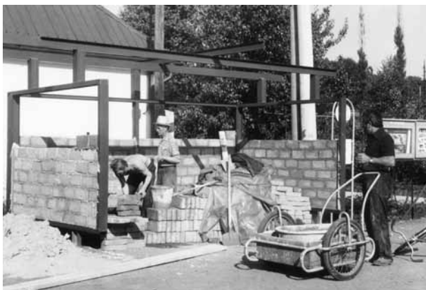
Výstavba nové autobusové zastávky v centru obce, 80. léta 20. století
