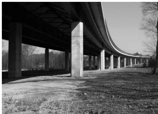
Estakáda rychlostní komunikace R48 nad údolím Stonávky v Horních Třanovicích, r. 2010
