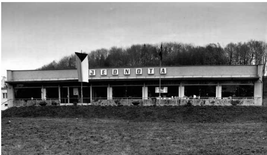
Novostavba prodejny Jednota v Třanovicích, r. 1976
