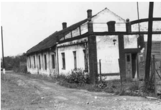
Bývalá strojní stanice na Dolině, 60. léta 20. století
